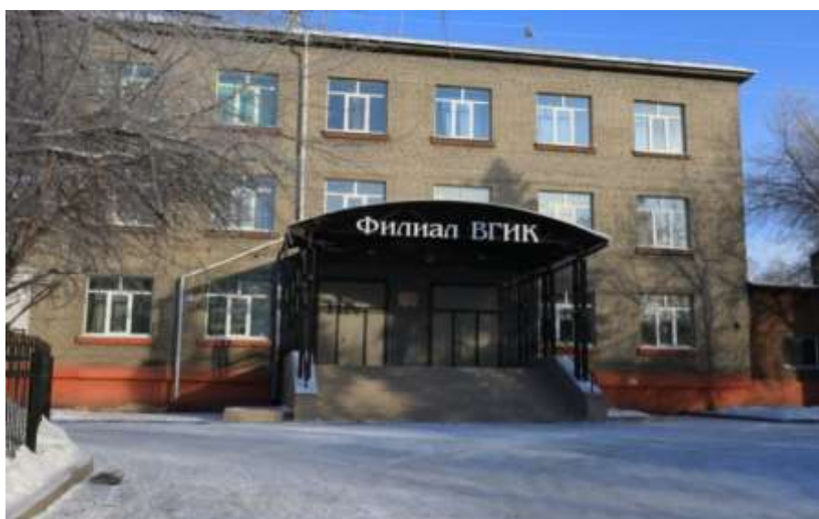
Рисунок 1 – Главный учебный корпус, г. Иркутск, ул. Розы Люксембург, д. 170.
